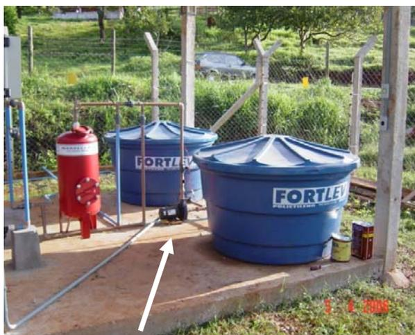
**FIGURA 20** Cabeçal de controle, destacando-se os reservatório de água potável e água residuária, conjunto motobomba centrífuga utilizado para irrigação e o filtro de areia.
