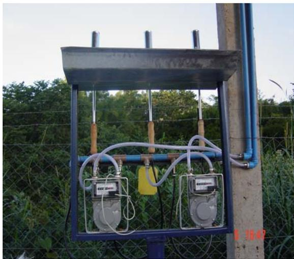
**FIGURA 16** Sistema de queimadores de gás tipo maçarico.
