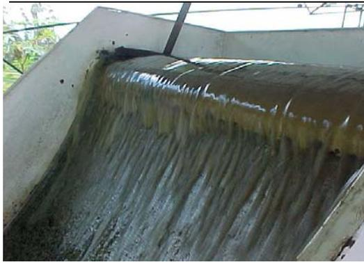
**FIGURA 6** Peneira estática para a remoção de sólidos dos dejetos
