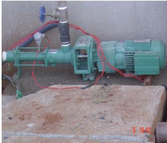
**FIGURA 8** Bomba NEMO que recalrava os dejetos da dorna até o RAC com uma vazão constante de  $1,6 \text{ L min}^{-1}$ .
