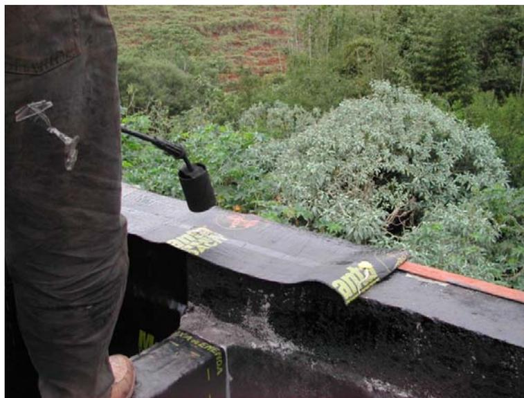
**FIGURA 15** Detalhe da preparação para o primeiro tipo de revestimento (com manta asfáltica) com moldagem a quente no reator tipo UASB.
