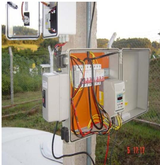
**FIGURA 9** Inversor de frequência que visava melhorar a eficiência do sistema de bombeamento.
