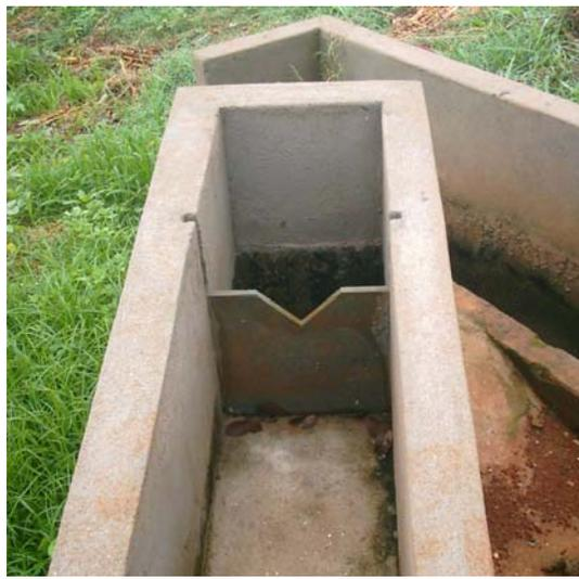
**FIGURA 5** Caixa de areia (desarenador) com medidor de vazão de Thompson de ardósia.
