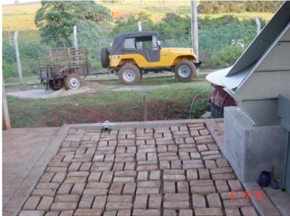
**FIGURA 7** Vista lateral do leito de drenagem onde caíam os resíduos sólidos dos dejetos, após peneiramento.
