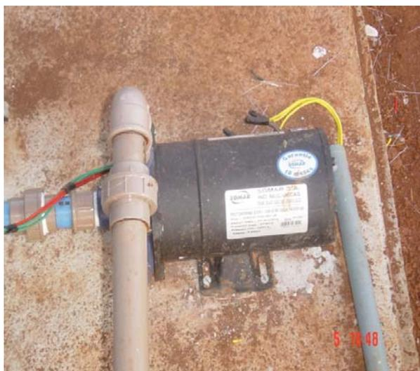
**FIGURA 19** Conjunto motobomba para o recalque do efluente da caixa de 3.000 litros até o reservatório de 1.000 litros no cabeçal de controle
