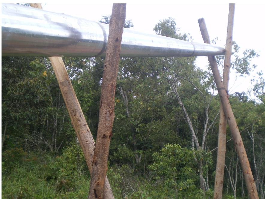
Figura 7 – Postes de madeira afixados ao solo formando “X” para sustentação do tubo coletor de líquido pirolenhoso.
