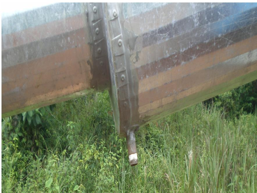
Figura 4 – Detalhes da pingadeira, responsável pela passagem da fração condensável dos gases emanados pelo forno rabo quente durante o processo de carbonização.
