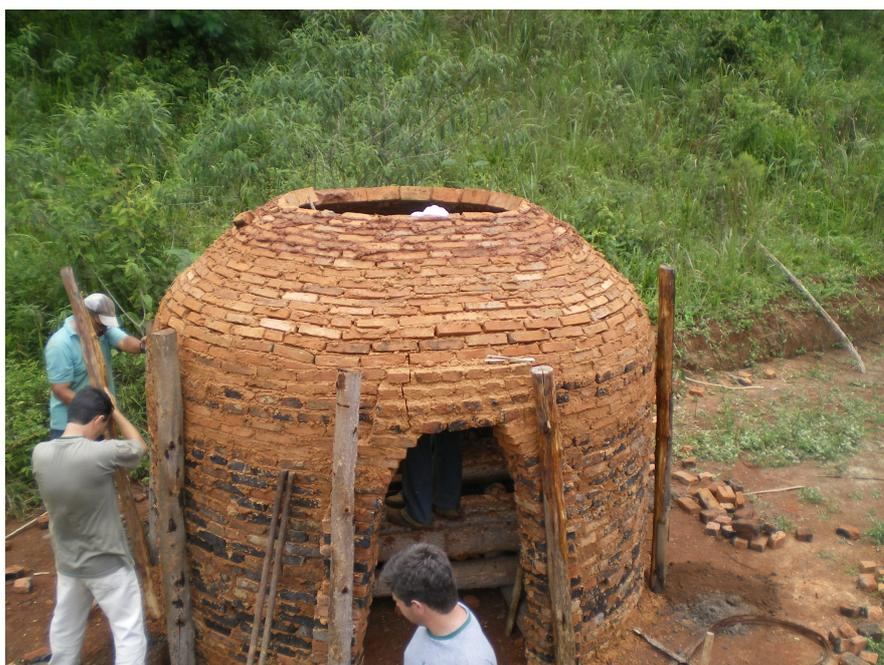
Figura 2 – Fechamento da cúpula do forno rabo quente e instalação dos postes de fixação.
