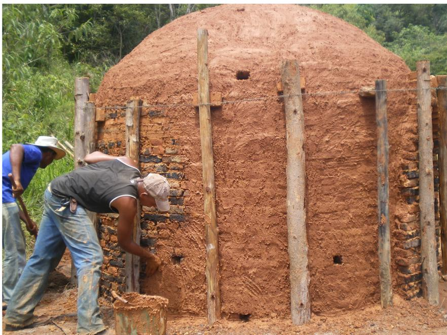
Figura 3 – Acabamento final do forno rabo quente realizado com uma fina camada de barro.
