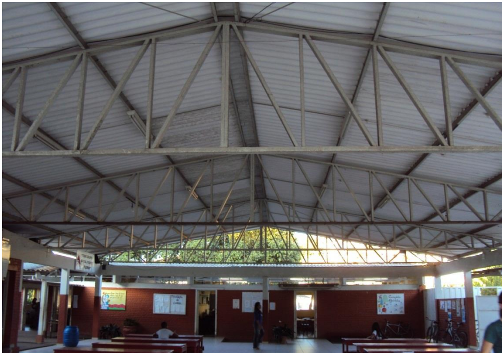
Figura 3 – Cobertura do pátio principal da escola
