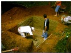
Imagem 2: Impermeabilização das paredes e fundo do Tevap
