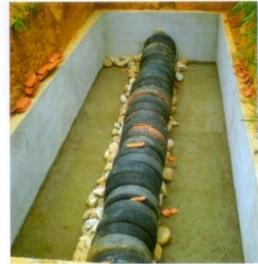
Imagem 8: Duto de pneus da câmara anaeróbia
