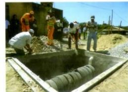
Imagem 14: Tubo de entrada do efluente posicionado para dentro da câmara anaeróbia
