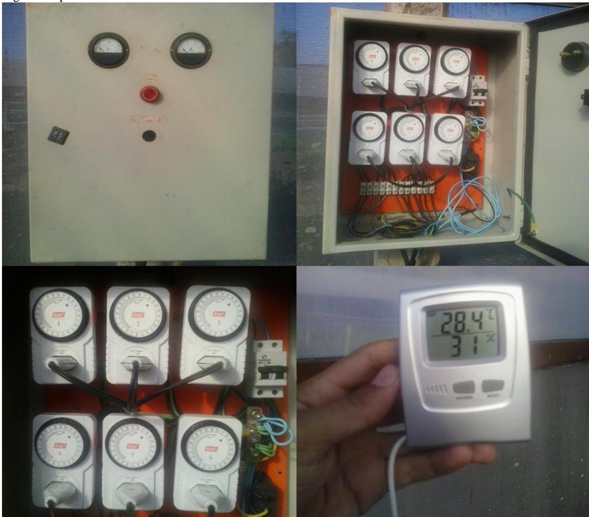
Fonte: o autor. Painel de controle com os seis temporizadores de regulagem manual com chave de acionamento geral e individual, termo higrômetro digital com marcação de temperatura interna/externa, máxima/mínima e umidade relativa do ar.
